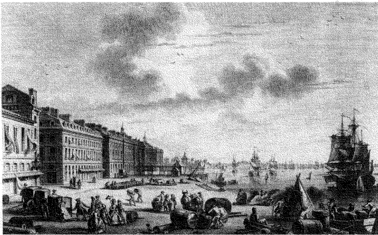
ボルドー港の様子(18 世紀後半)
