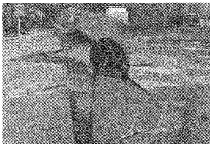
地面より高くなったマンホール
